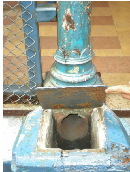
Descarga de aguas pluviales
