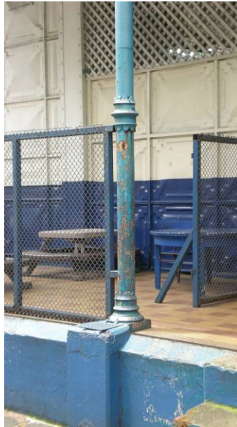
Columna del sector oeste
