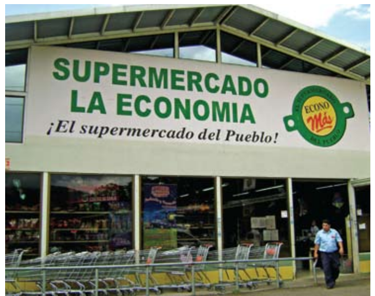
Estructura de acero en buen estado. Nótese la integridad de las ventanas y sus cristales.
