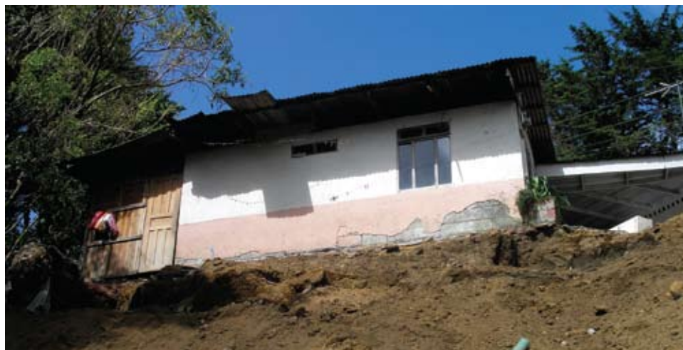
Vivienda al borde de un talud inestable.
