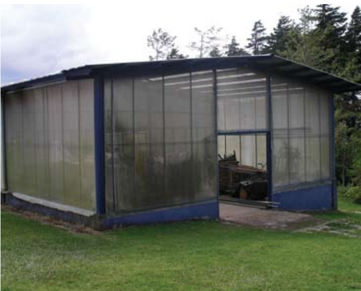
Marco de acero laminado en frío cerca de Fraijanes sin ningún daño.
